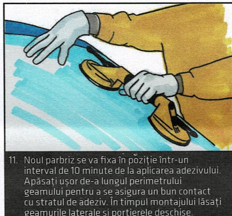
11. Noul parbriz se va fixa în poziție într-un interval de 10 minute de la aplicarea adezivului. Apăsați ușor de-a lungul perimetrelui geamului pentru a se asigura un bun contact cu stratul de adeziv. În timpul montajului lăsați geamurile laterale și portierele deschise.
